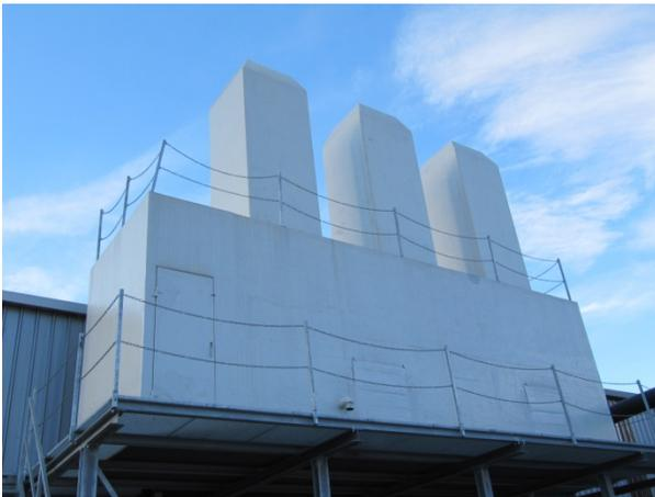
Bild: ein HK-Bio-Luftwäscher mit einer Reinigungsleistung für 75'000 m<sup>3</sup>/h
