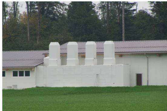
Bild: HK-Bio-Wäscher (Kapazität: 100'000 m<sup>3</sup>/h)
