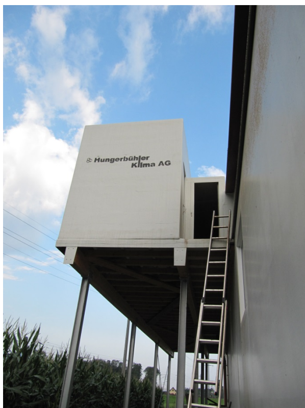
Bild: ein HK-Combi-Luftwäscher mit einer Reinigungsleistung für 100'000 m 3 /h
