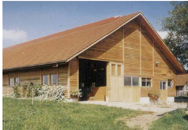
Bild: Luft-Licht-First auf Ziegeldach
