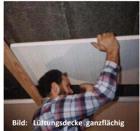
**Bild: Lüftungsdecke ganzflächig**
