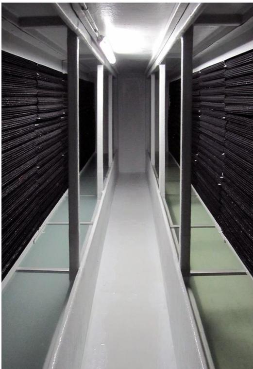
Die Abluftreinigung des HK-3-Phasenluftwäschers erfolgt in drei separaten Phasen und eignet sich somit speziell für Abluft mit besonderer Problemstellung (sehr starke Gerüche , hohe Ammoniak oder Schwefelwasserstoffkonzentrationen, etc.).
