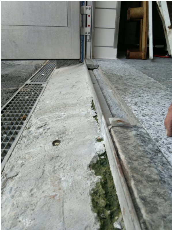
Bild: Sanierung der Türschwelle und gleichzeitig erstellen einer Desinfektionswanne vorher....
