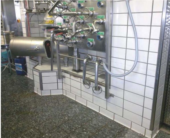
Bild: Wandsanierung einer Käserei vorher....
