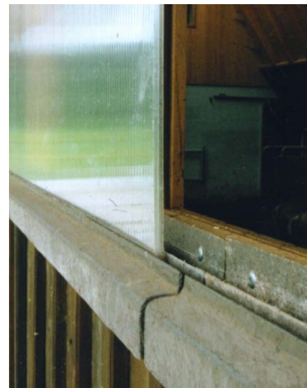
Bild: Führungsschiene mit Doppelnut
